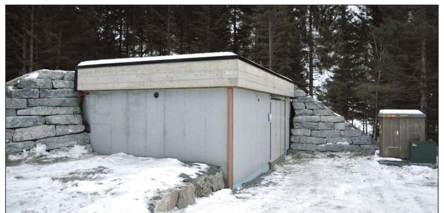
SNART I GANG: I løpet av denne månaden vil innbyggjarane i Balestrand få vatn frå det nye vassverket i Esebotn i springen. Ni år etter vedtaket vart gjort og fire månader etter det dei håpa i fjor haust. (Foto: Eirik Thue)
